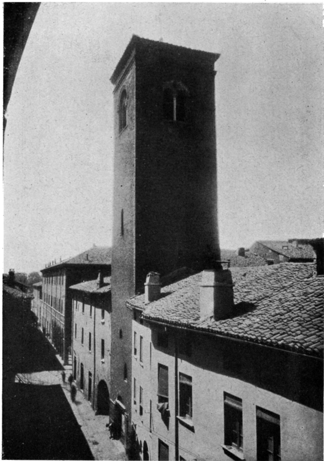
La torre Campanaria
